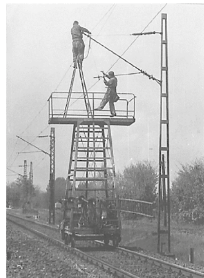
4. kép: Felsővezeték-építés a villamosítás korai időszakában
