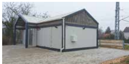
Az Esküdt utcai technológiai épület
