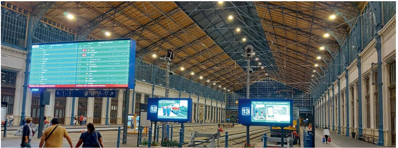
A csarnok világítása üzemben (forrás: saját fotó)
