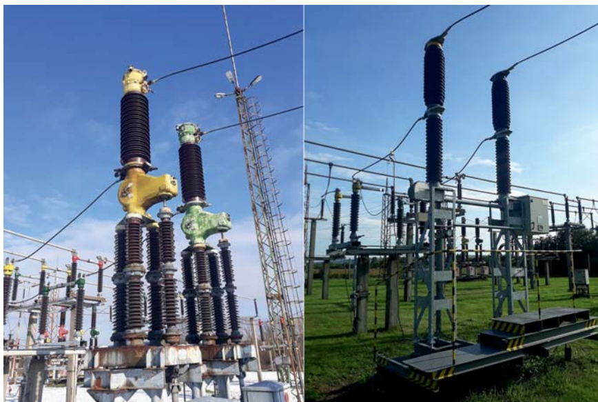
A 120 kV-os, oldali régi és új megszakítók
