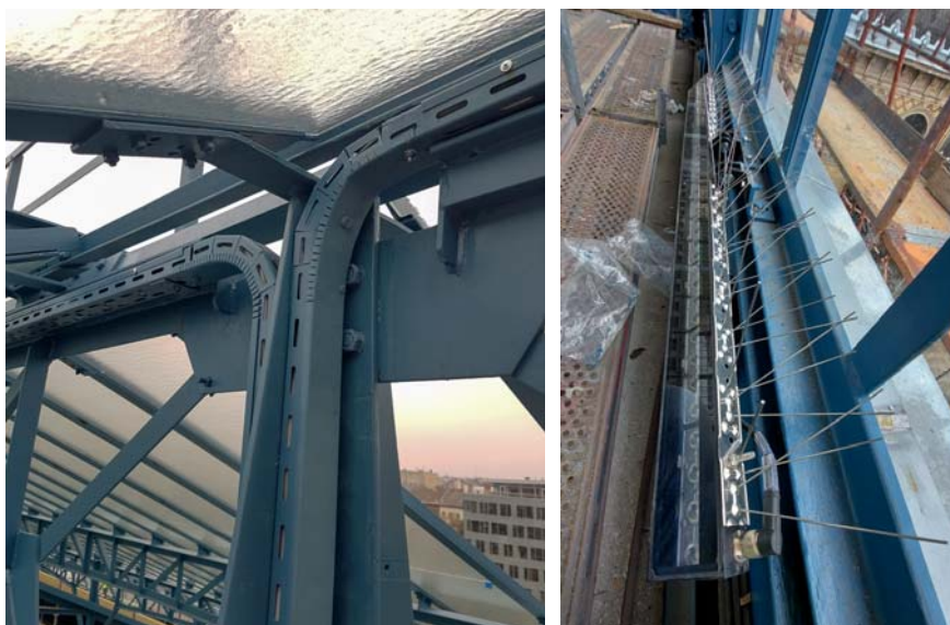
Fém kábeltálcák rögzítése és Scupline világítótest a főpárkányon (forrás: saját fotó)
