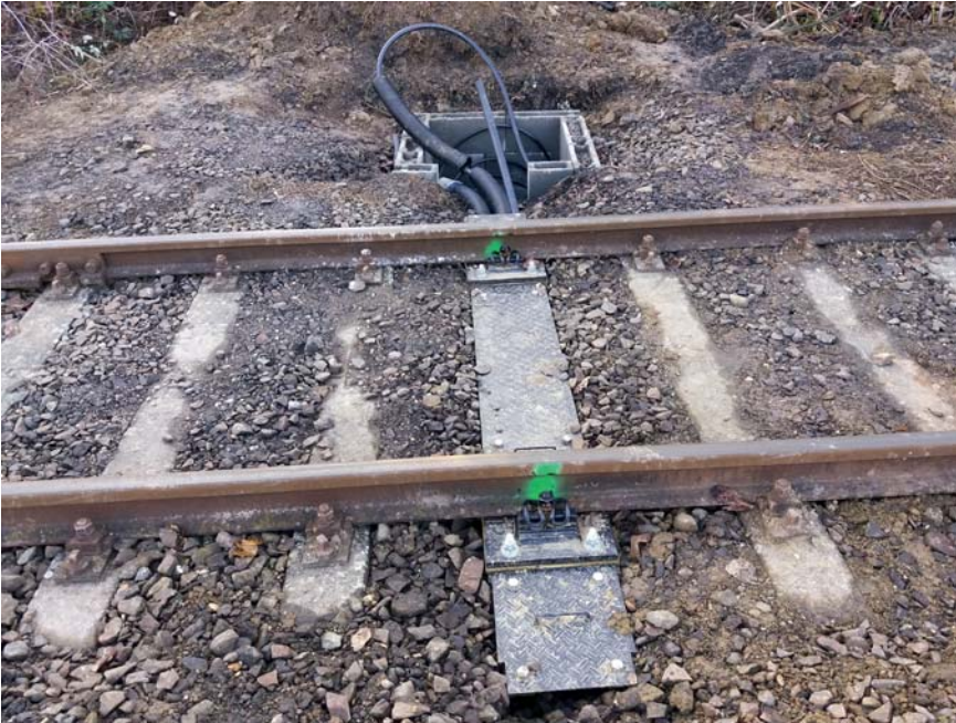
Vályúaljás kábelátvezetés
