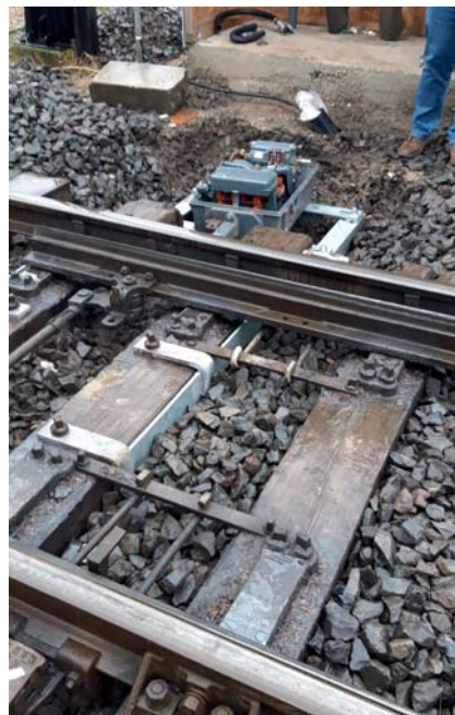
Váltóhajtómű felszerelése
