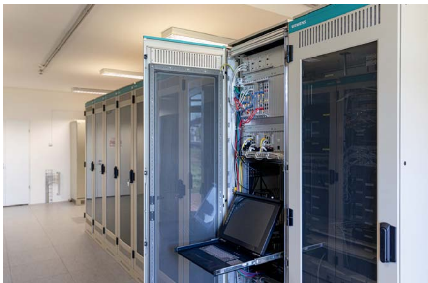
Siemens RBC központ Martonvásár állomáson
