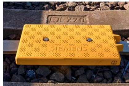
Siemens baliz Martonvásár állomás IV. vágányán
