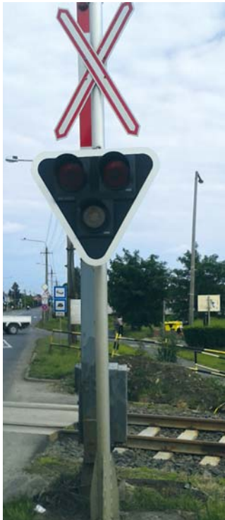
4. kép XJ jelfogós sorompóberendezés 200 mm-es izzós Futurit optikával Püspökladányban (2015)
