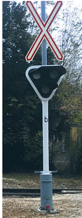
5. kép BUES 2000 útátjáró (AS99) az átalakítást megelőzően Gencsapátiban (2017. nov.)
