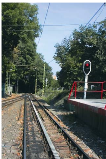
6. ábra: Forgalmi kitérő megállóperonnal a fogaskerekű vasúton
