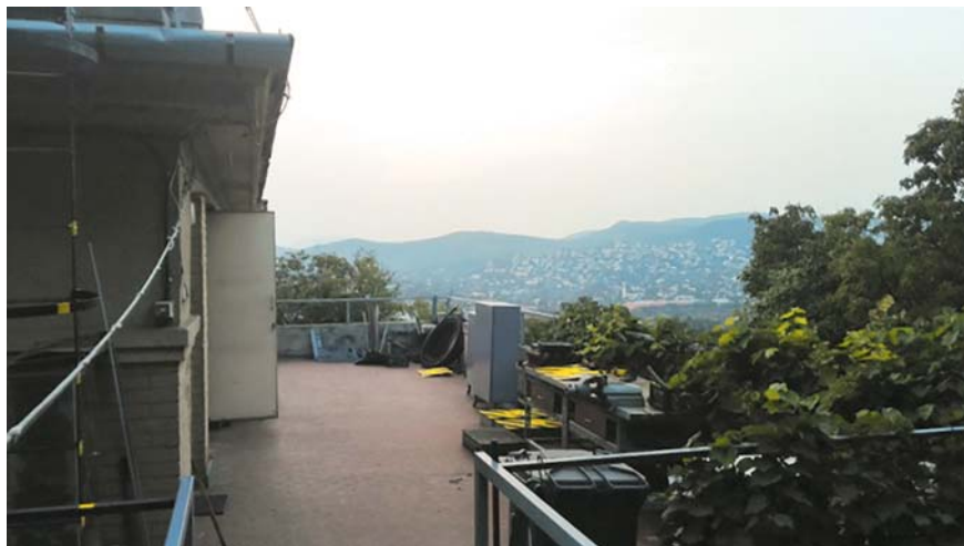
4. ábra: A jelfogóhelyiség épülete a panorámás terrasszal
