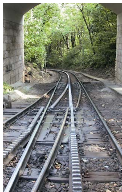
8. ábra: Speciális, fogasrudas kitérő
