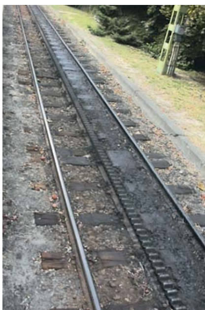
7. ábra: Amortizált és szennyezett felépítmény
